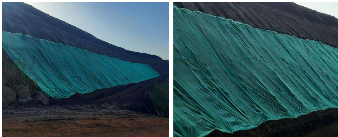
Figura 5 - Implantação de telas visando minimizar a emissão de particulados através da ação eólica nos taludes da Pilha do Pátio D
