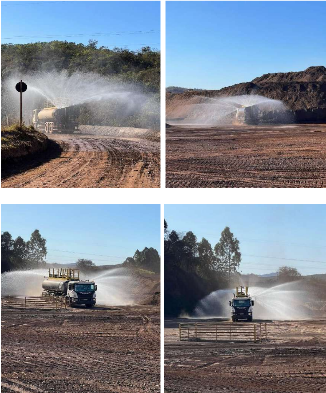
Figura 3 - Aspersão das vias internas e de acesso a LGA através de caminhão pipa
