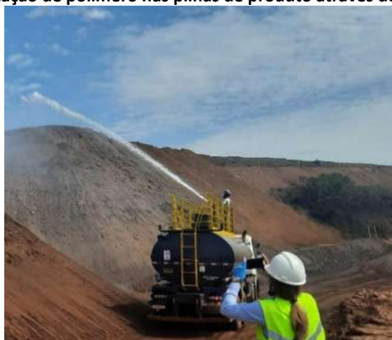
Figura 6 - Aplicação de polímero nas pilhas de produto através de caminhão pipa
