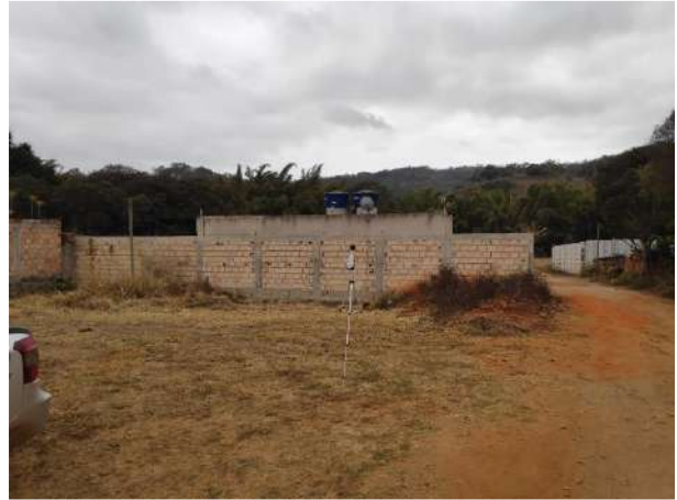
Figura 11.32 – Ponto de Monitoramento de Ruído Ambiental – PR02
