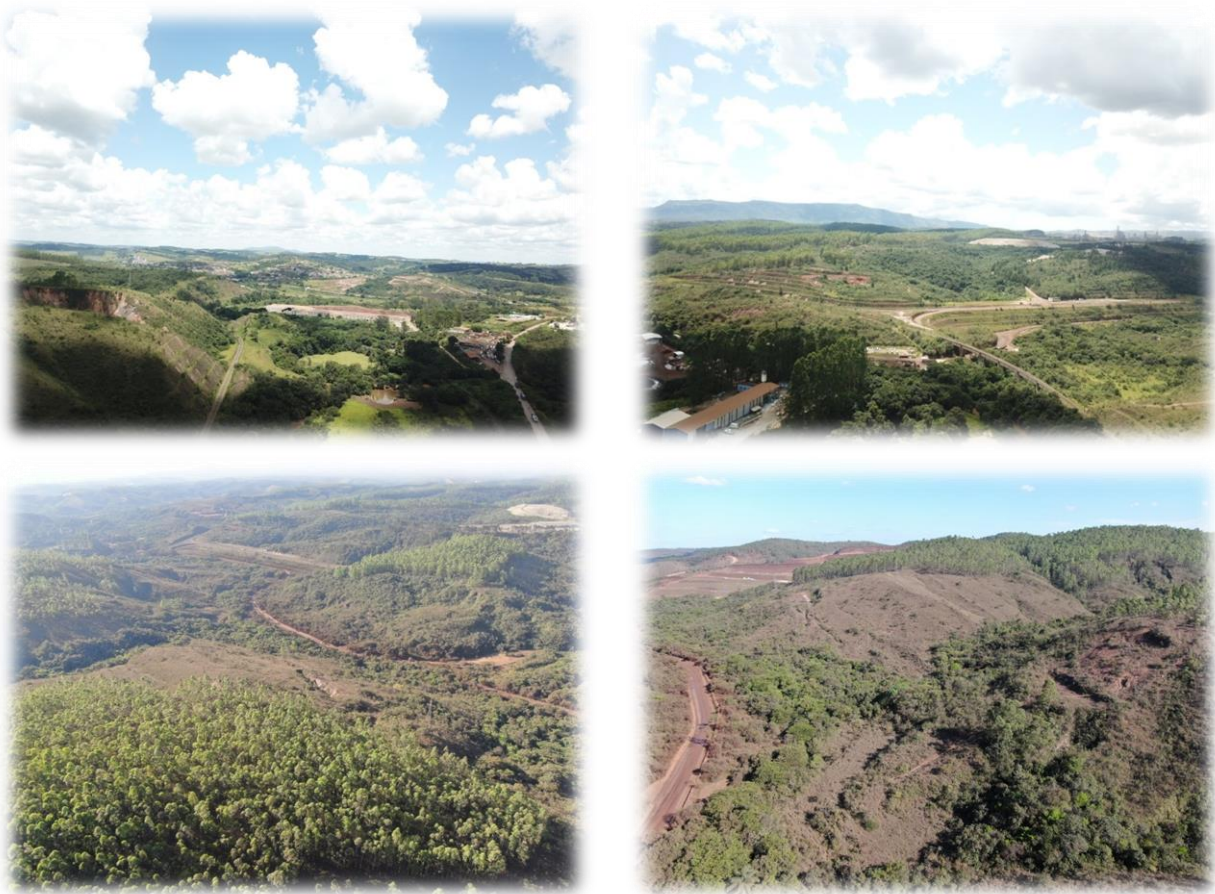
Figura 6.7 - Vista parcial da região do projeto e sua adjacências, onde se observa as modificações da paisagem original causadas por diferentes intervenções antrópicas
