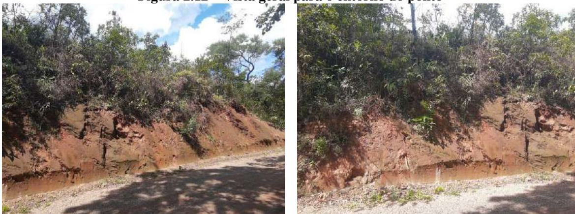
Figura 2.12 – Vista geral para o entorno do ponto
