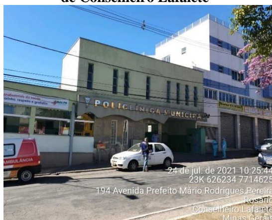
Figura 11.97 - Vista Policlínica Municipal de Conselheiro Lafaiete
