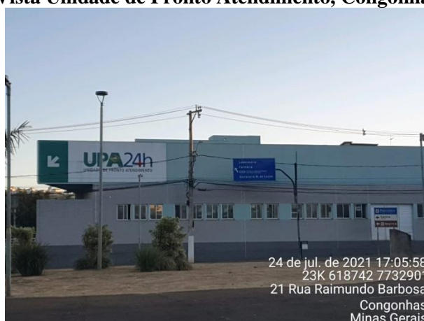
Figura 11.37 - Vista Unidade de Pronto Atendimento, Congonhas, Minas Gerais
