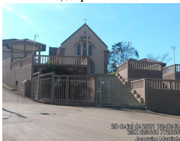
Figura 11.239 – Igreja Católica do Santo Antônio, Joaquim Murтинho
