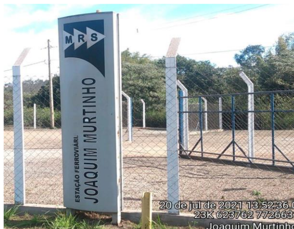
Figura 11.217 - Estação Ferroviária de Joaquim Murтинho, Conselheiro Lafaiete, Minas Gerais
