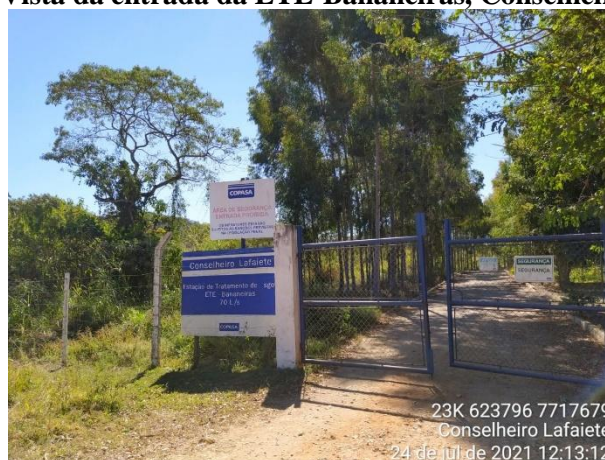
Figura 11.85 - Vista da entrada da ETE-Bananeiras, Conselheiro Lafaiete, MG
