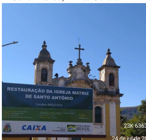
Figura 11.170–Igreja Matriz de Santo Antônio interditada para restauro, Ouro Branco, Minas Gerais.
