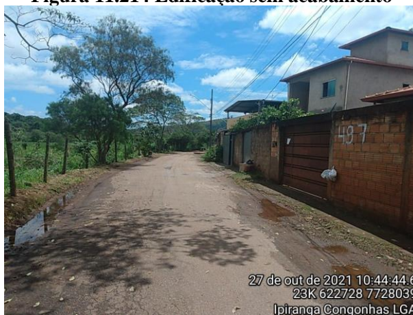
Figura 11.214 Edificação sem acabamento
