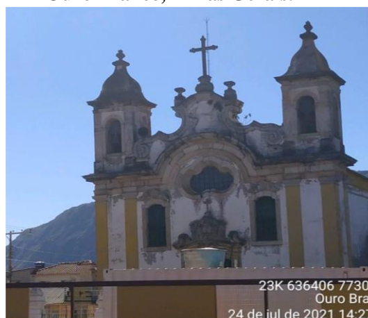
Figura 11.171– Fachada da Igreja Matriz de Santo Antônio interditada para restauro, Ouro Branco, Minas Gerais.
